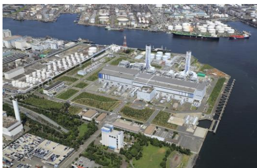
(株)JERA 川崎火力発電所
